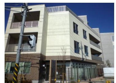
宮前地区会館「まじわーる宮前」外観
